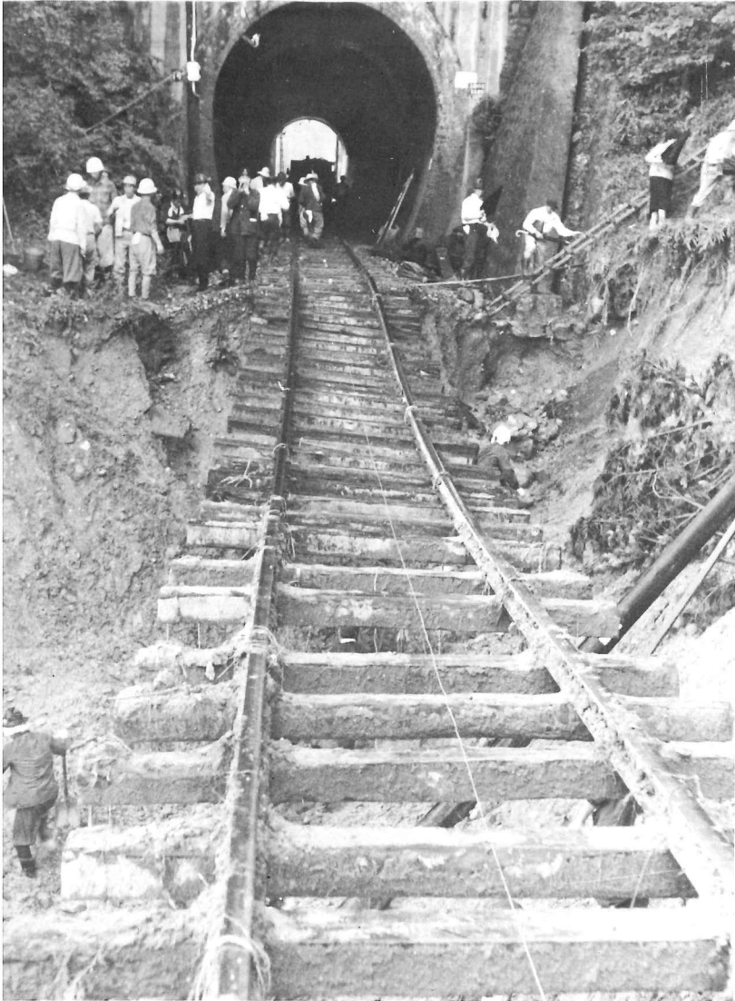
寺井崩落により、宙づりとなった飯田線。
