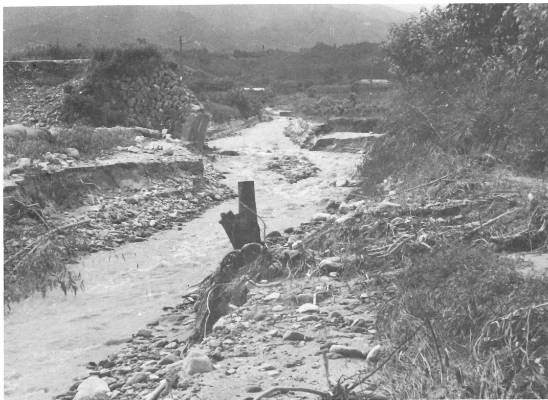
土曾川 金井戸橋下から上流を望む。(橋は流失)
