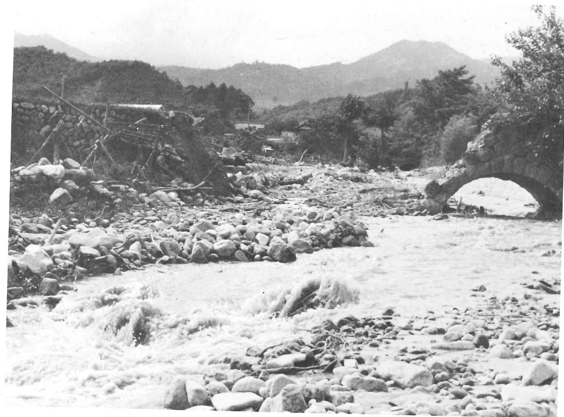
崩壊した土曾川 五郎田橋。遠方に国道の隧道が、半分以上埋って見える。
