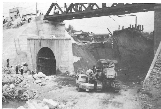
② 災害の原因のひとつ となった、桜町境の 鉄道隧道（南側）
