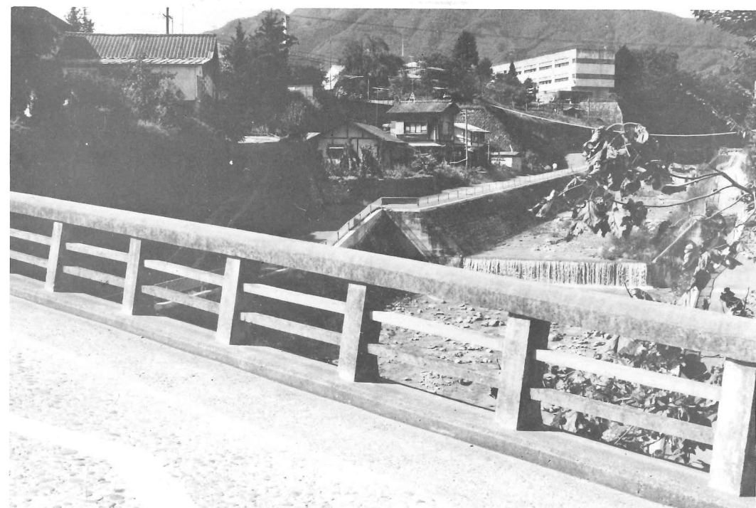
復旧なった小伝馬橋と上付近
