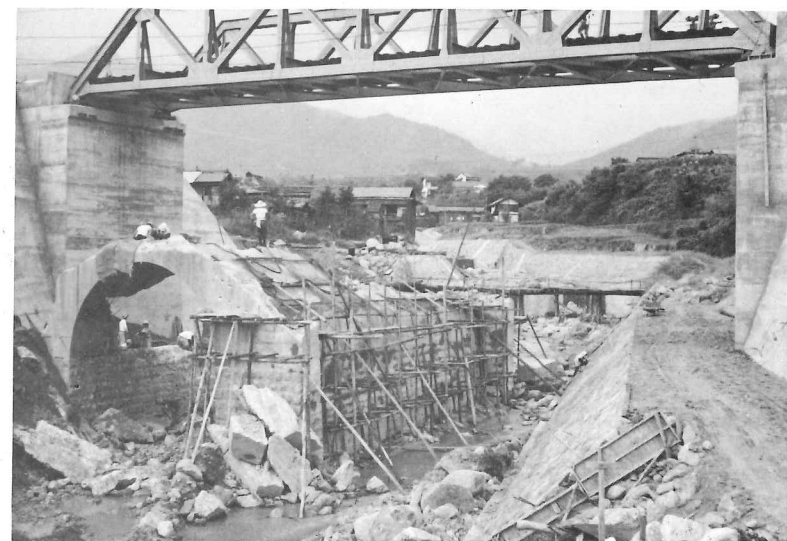
③ 隧道取壊し作業
