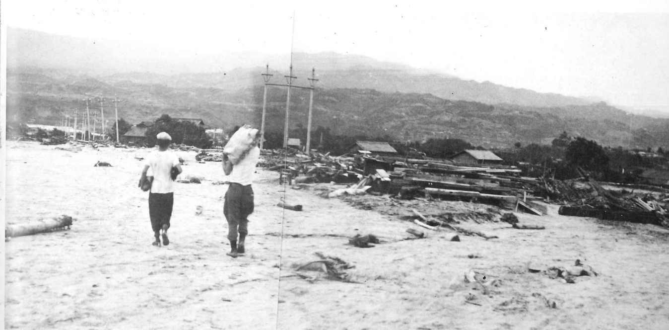
加賀沢の堤防決壊により、天王原は、一面、砂河原となってしまった。（夜泣石下付近から下方を写す）
