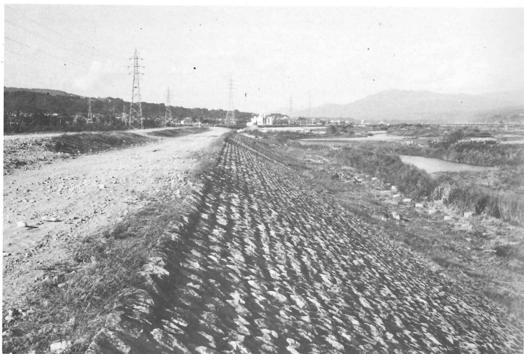
復旧なった同所
