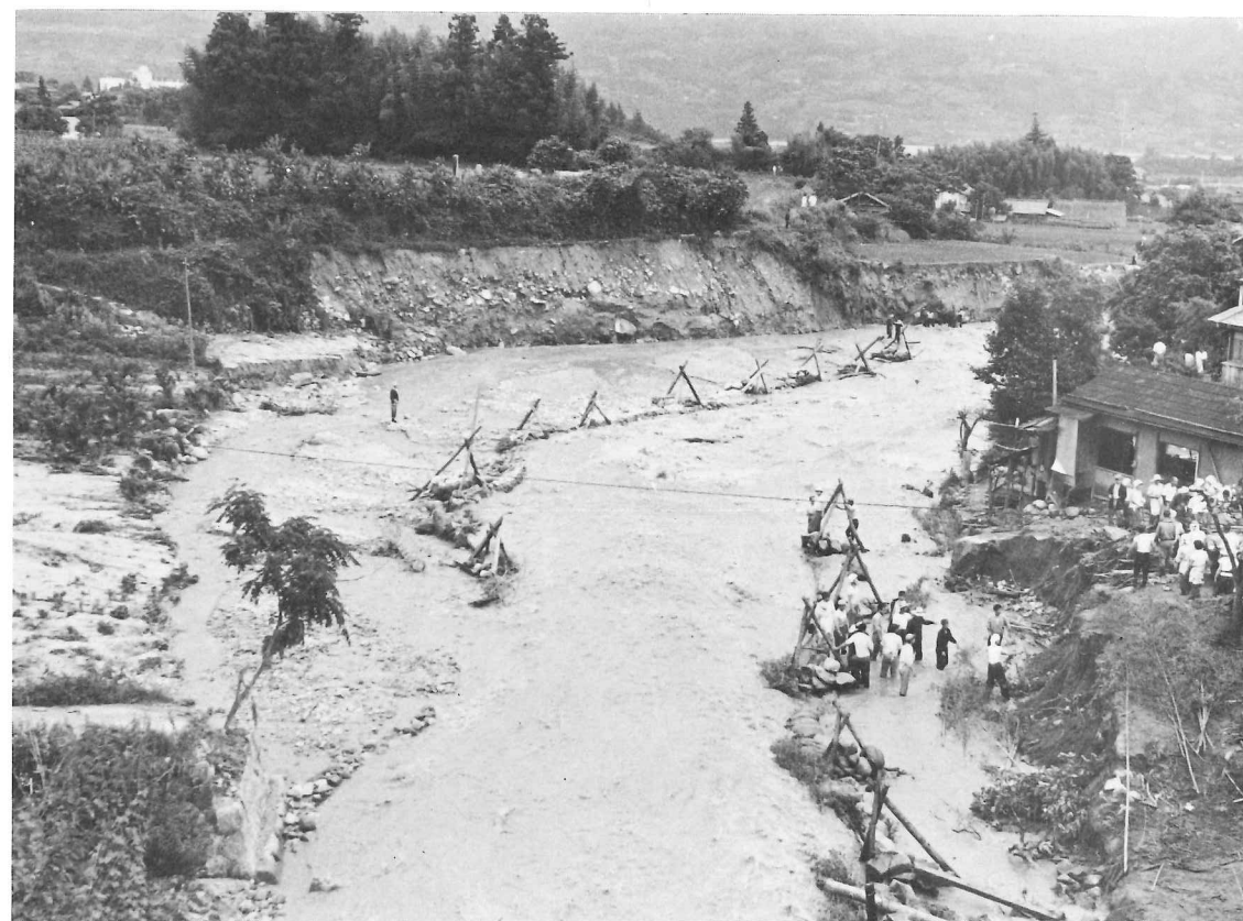
野底川 都出橋下。都出橋も流失した。
