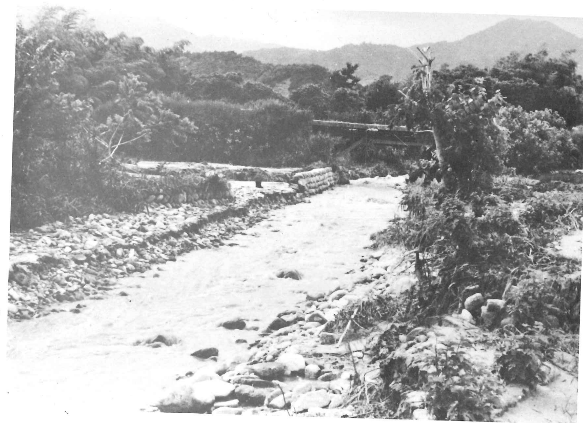
土曾川 堂垣外橋付近
