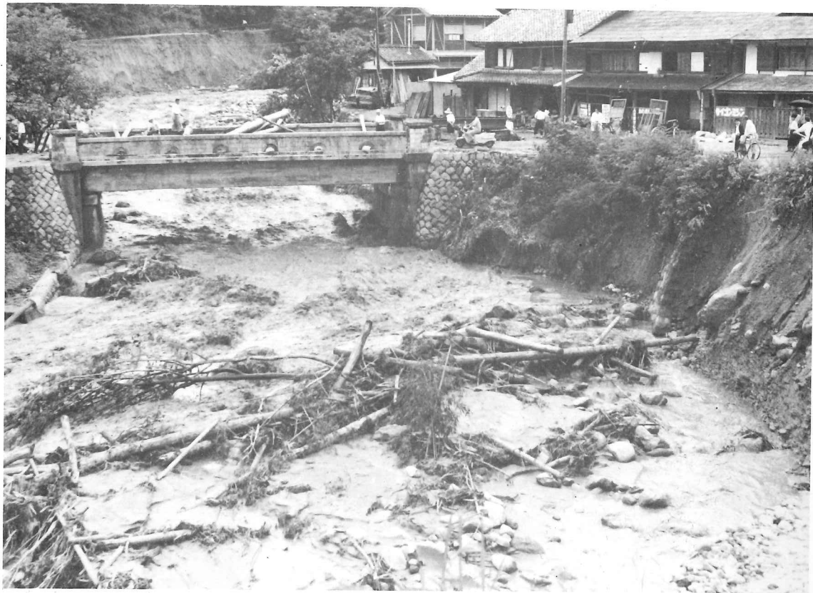
野底川 野底橋。どのようにして、橋の上まで木材が跳ね上がったのか？
