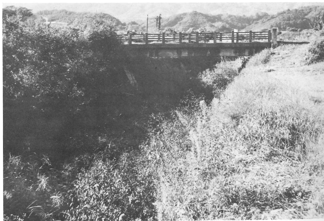
復旧なった同所
