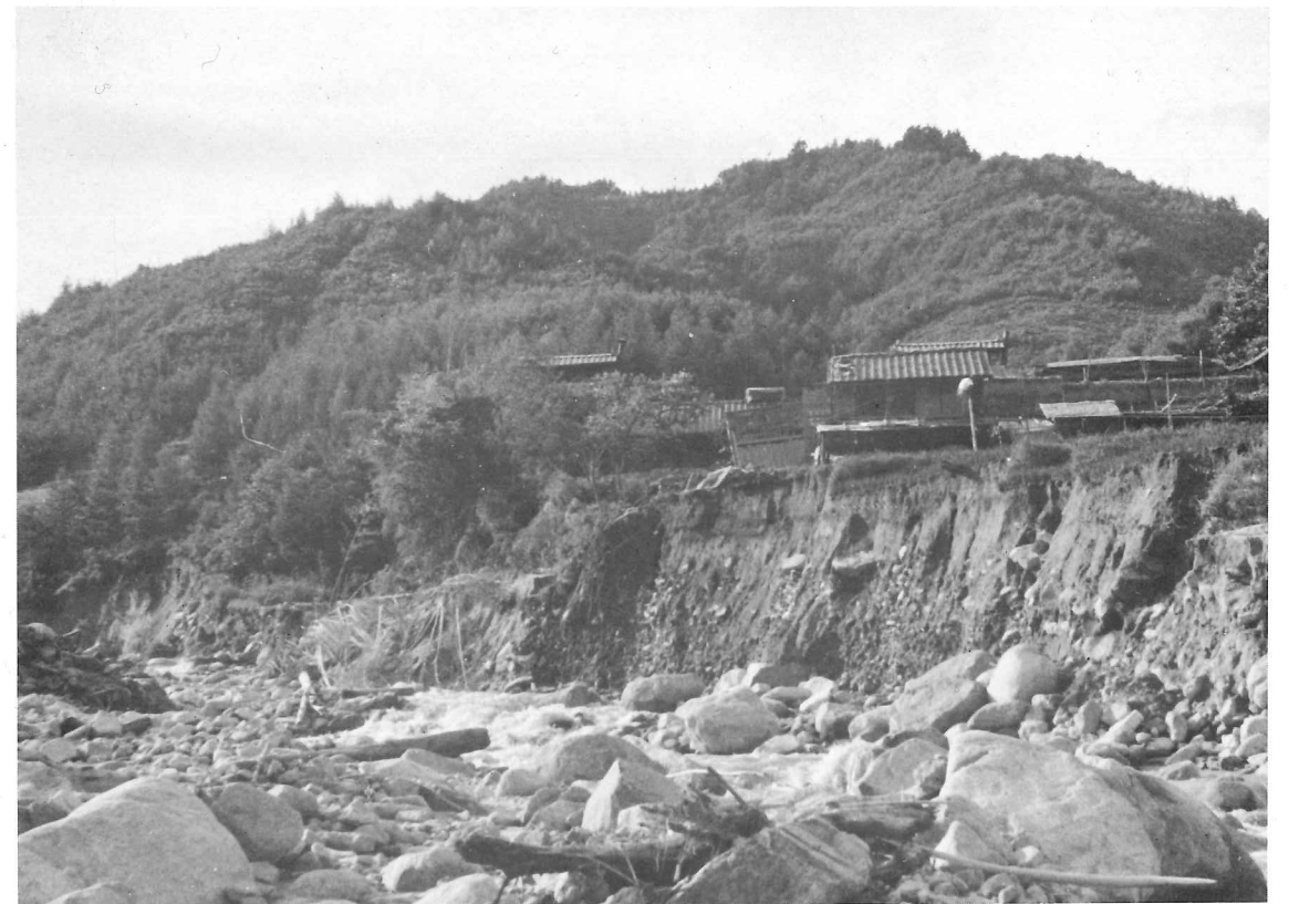
野底川 棚田橋上。農地が大きく崩落流失した。
