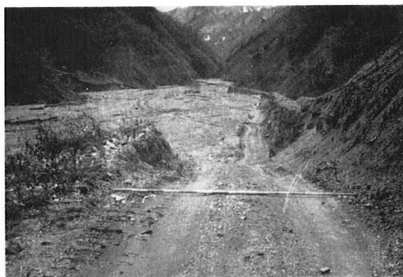
長谷村飯田茅野線被害状況
