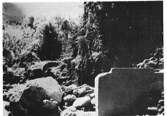
崩壊流失した水源池と接合井 （飯島町日曾利水道）
