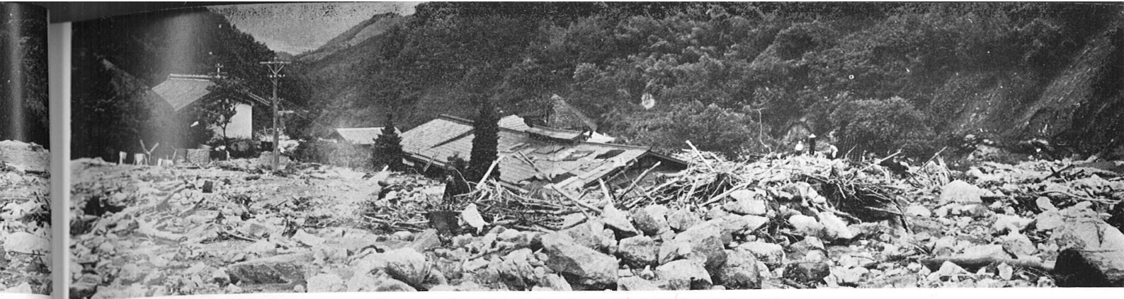
県工事 駒ヶ根市宇落合大洞（新宮川の内最上流部）
