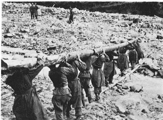
【自衛隊による架橋作業】
