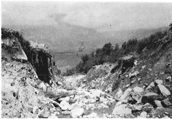
貯水接合井送水管被害状況 （中川村大草中組水道）
