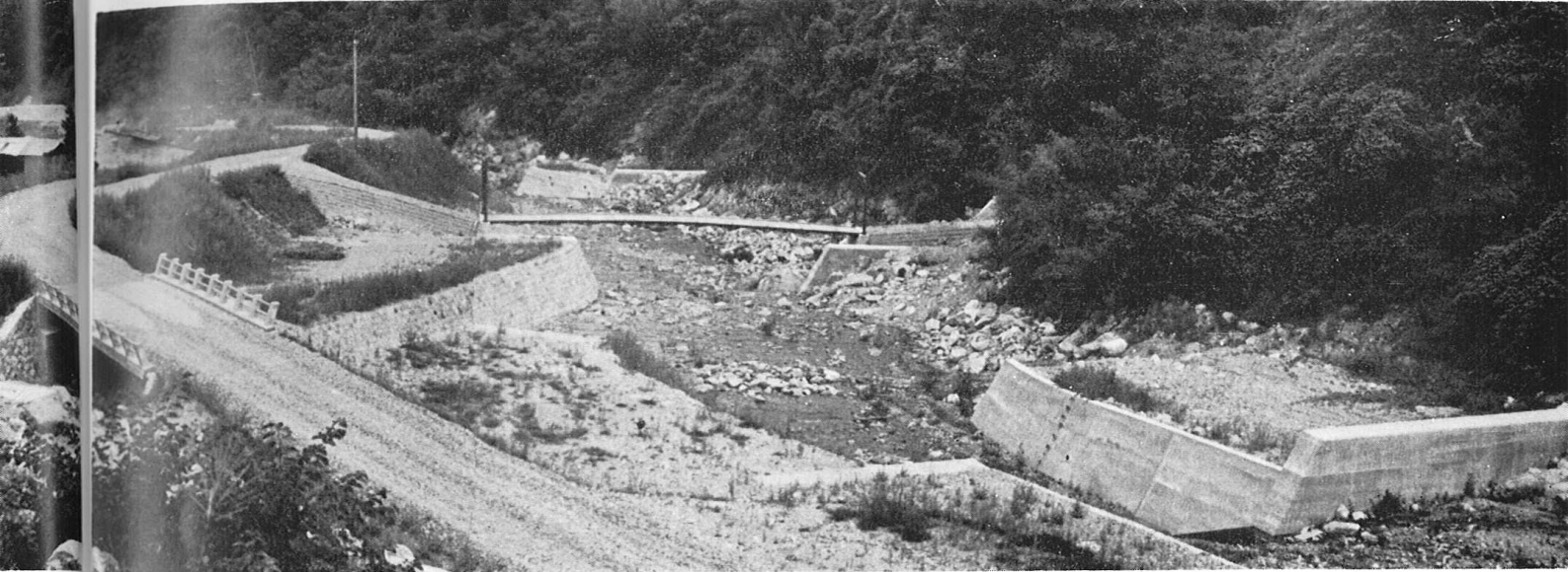
↑ 竣工 流路工長 L = 2,268m 落差工73基 橋梁2橋 C = 207,159 千円
