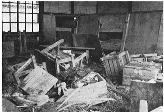
【黒板の下まで土砂流入した教室】
