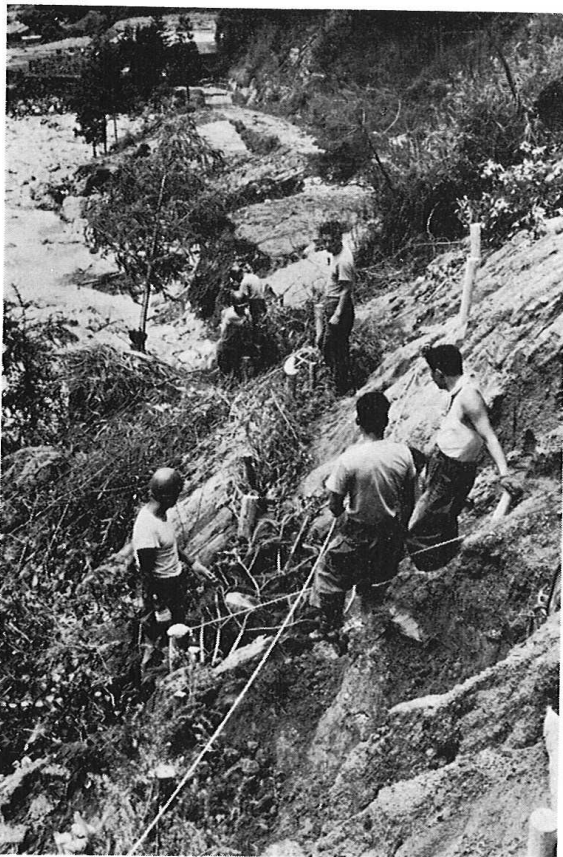
【自衛隊による林道応急工事（駒ヶ根市中沢桃平）】
