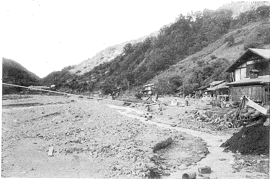
鹿塩川と鹿塩市場の氾濫跡
