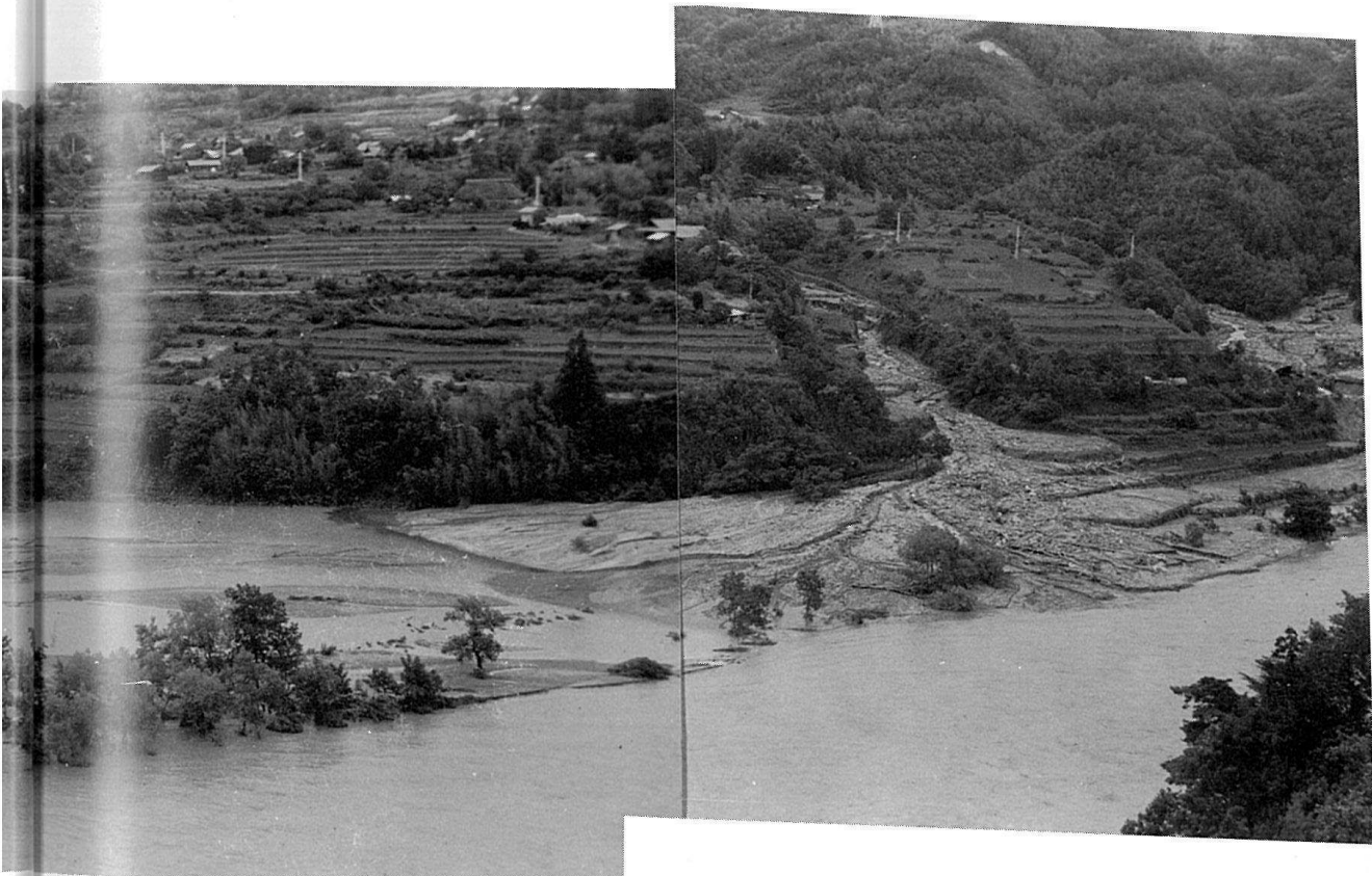
▲天龍川の氾濫 (片見山より見た日曾利河原) 36災害にて天龍川が満水となり各所に被害甚大上伊那の南部と下伊那の北部に特に被害あり死者多数家屋、林野、田畑の流失等大災害をもたらした (昭和36年6月27日写す)
