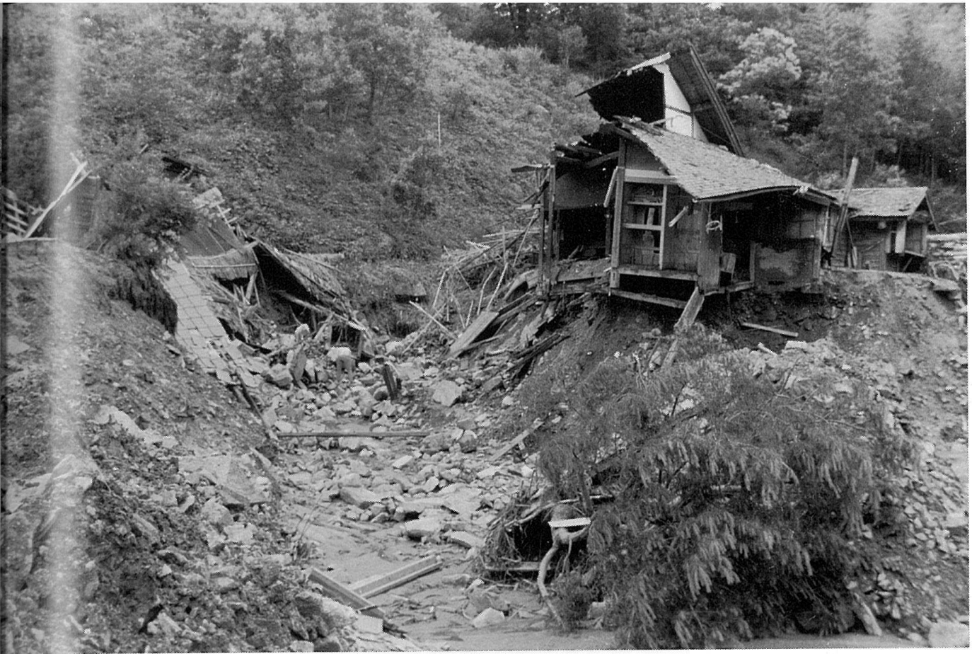
▲民家の流失状況 (日曾利)
