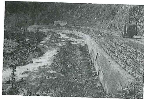
塩川林道 1,100m地点(駒ヶ根営林署管内) (37年復旧完成)
