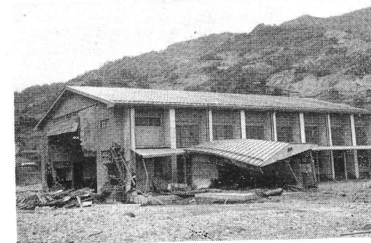
大西山の大崩落による強風のため 破壊された大河原小学校体育館
