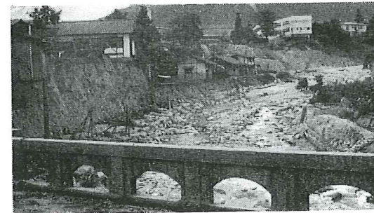
風越学校裏 被災と竣工
