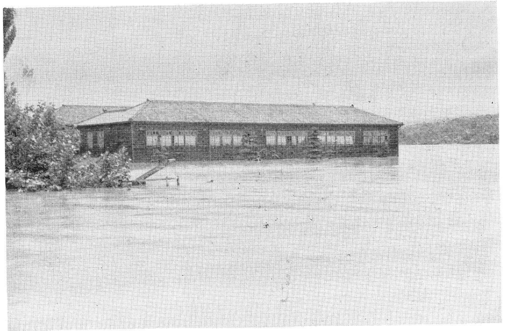
浸水した川路小、中学校（土台から6.45m浸水）
