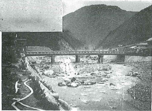
鹿塩川 鹿塩橋の異常埋堤の被災と復旧
