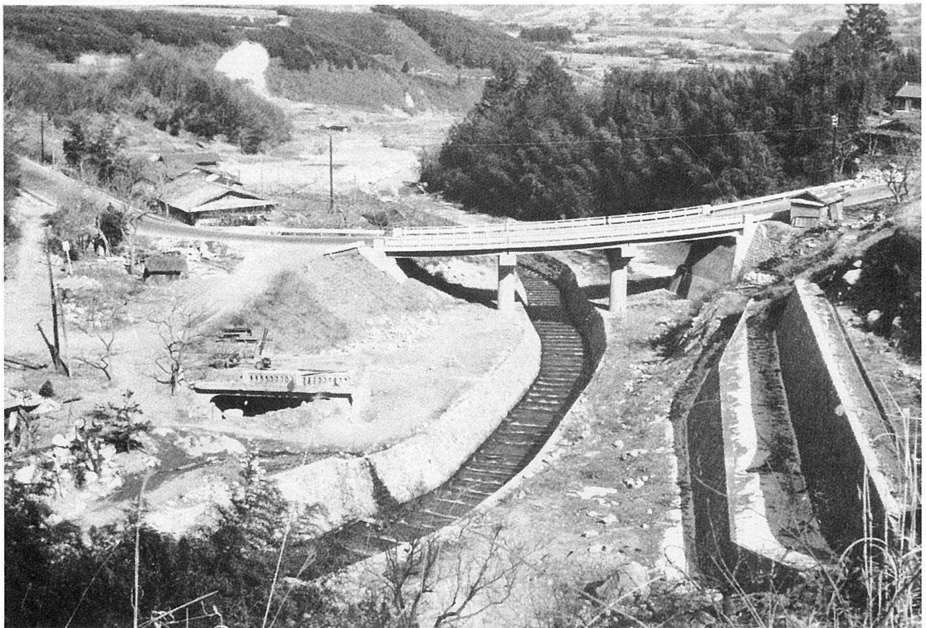
↑ 田沢川追分橋附近…… 6月27日夕方、小田沢川に発生した鉄砲水により、一瞬にして4戸の民家を流失し、8名の犠牲者をだした。……田沢川は38年に復旧され、同時に県道も付け替えられて新しい追分橋が出来た。 ↓ 又旧橋はそのまま残っていた。
