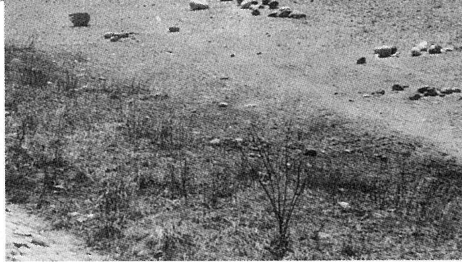
↑復旧された堤防
