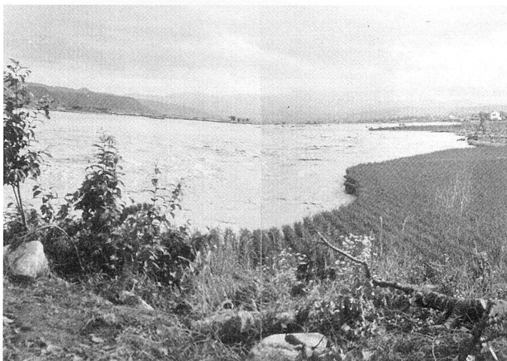
↑ 堤防が欠潰して濁流の流れる下市田河原一上流から見る、遠方右手建物は農試
