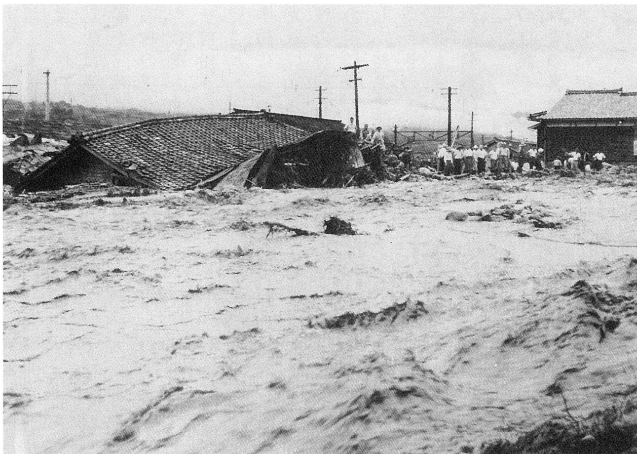
↑大島川の濁流に洗われる住宅 一市田駅の貨物ホームの西方附近、右手が上流吉田側から写す
