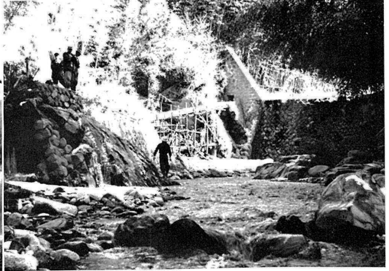
中沢下井頭首工被災(上)と完成(左)
