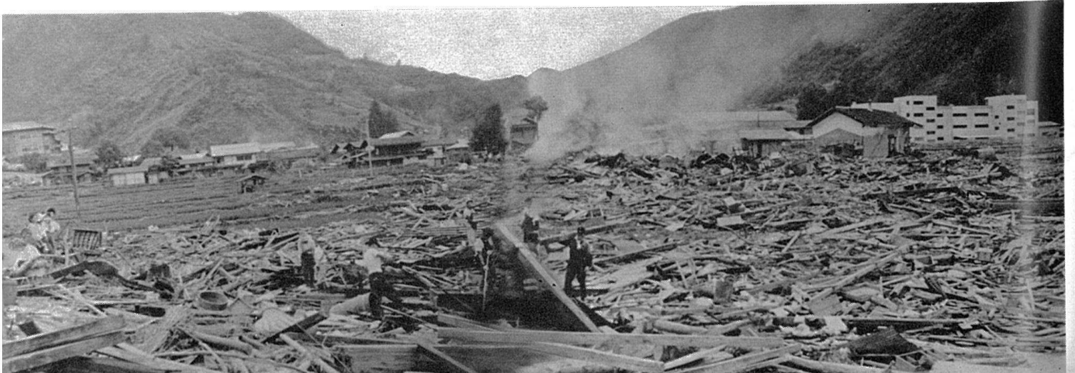
大西山の崩壊による家屋倒壊の惨状
