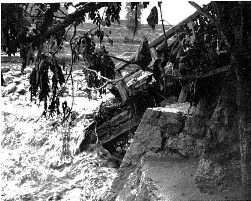
流失切断された下曾倉橋
