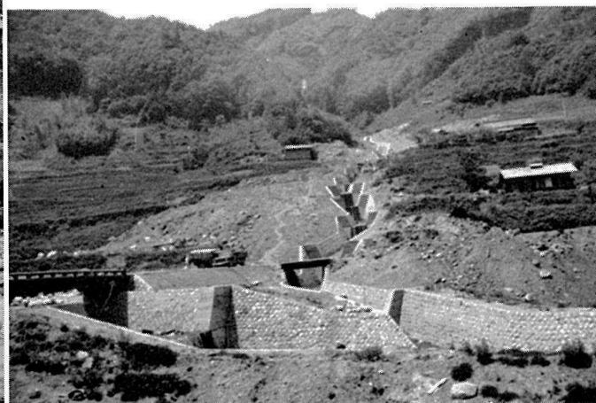
大角洞 被災(左)完成(下)
