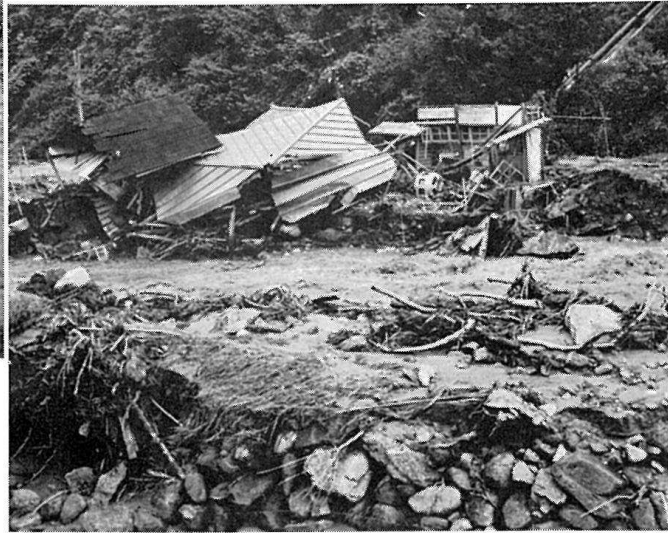
壊滅した発電所
