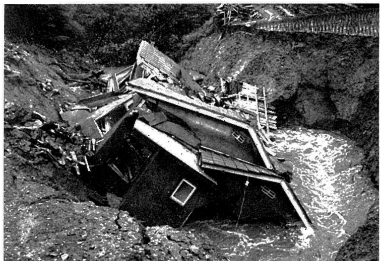
倒壊した新築したばかりの家
