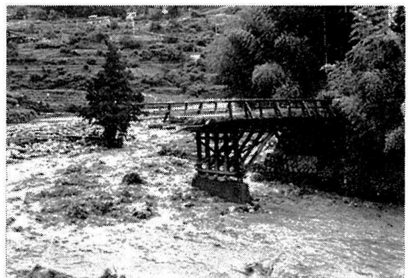
大 坪 橋 (道平橋)
