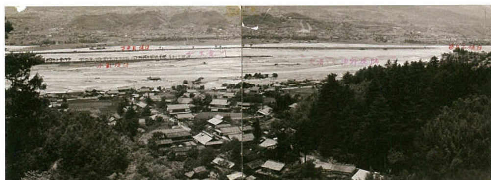
④85 写真提供：片桐 智明様 昭和 36 年 天竜川 豊丘村源道地 決壊した伴野堤防。伴野堤防（中央）が決壊して、次に惣 兵衛堤防（右）が決壊した。手前の家屋は災害には救われた。
