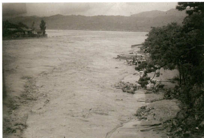
④84 写真提供：平沢 勝彦様 昭和 36 年 天竜川 飯田市川路 高校の同級生より借りた写真。 梅雨前線豪雨、どこの橋か分 からないが、橋の上より見おろす。
